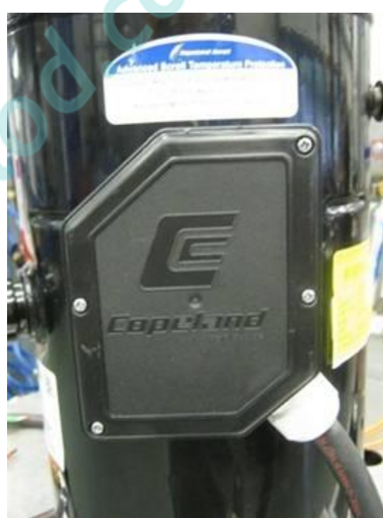
Рис 11: Правильное электрическое подключение клеммной коробки IP54 с помощью кабельных муфт
