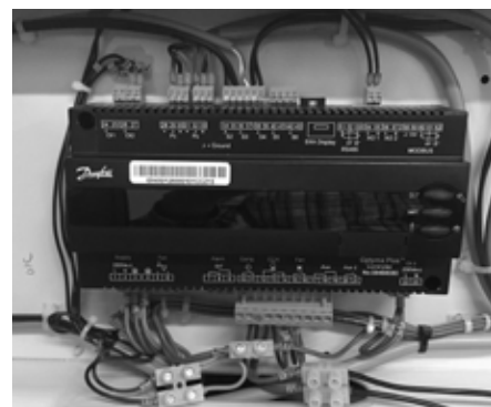
Rysunek 4: Okablowanie tymczasowe
