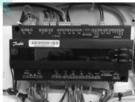
Rysunek 3: Okablowanie normalne
