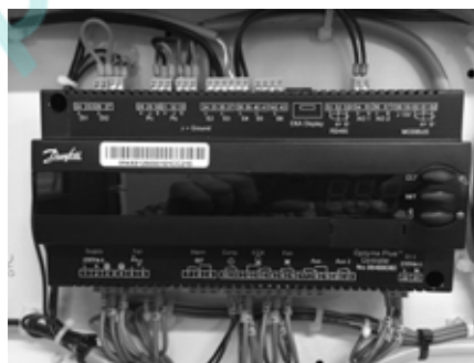
Illustration 3 : Câblage normal
