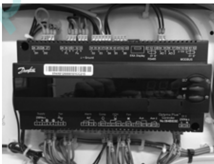
Bild 3: Normale Verdrahtung
