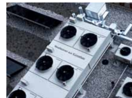
Конденсатор с осевыми вентиляторами
