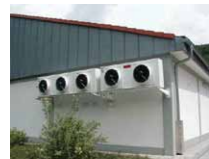
Небольшие холодильные установки с вентиляторами ZIEHL-ABEGG
