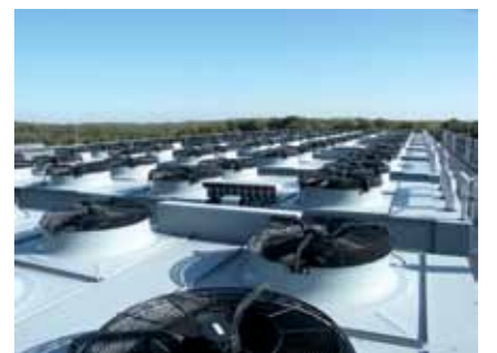
Конденсатор с осевыми вентиляторами
