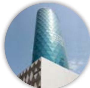
Бизнес-центр Millennium Tower, Манاما, Бахрейн
